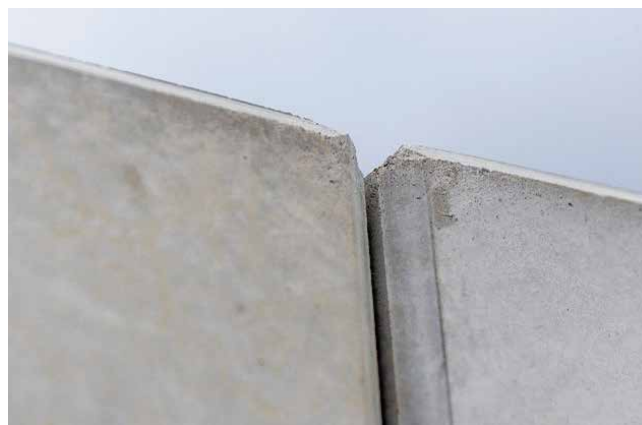
Joints entre éléments
