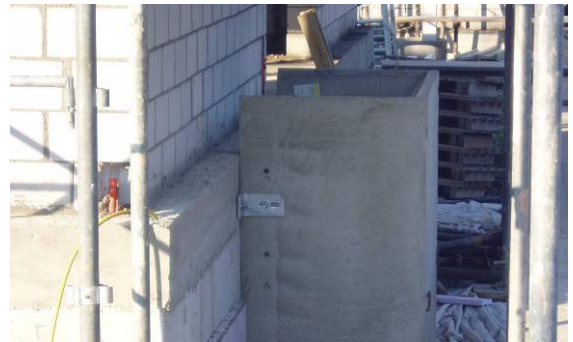
Bild 36: Befestigungswinkel Typ KLEIN
