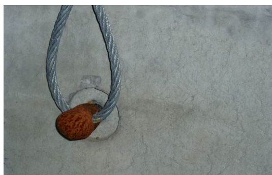
Bild 24: Drahtseilschlaufen MRd 12 oder MRd 16
