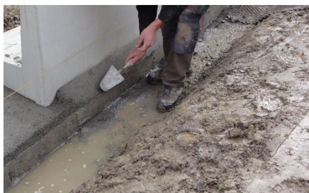
Bild 30: Erstellen der Fundamentnocken
