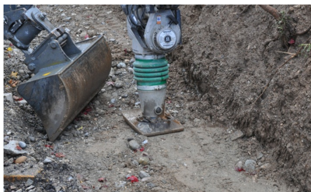
Bild 26: Erstellen der Sauberkeitsschicht
