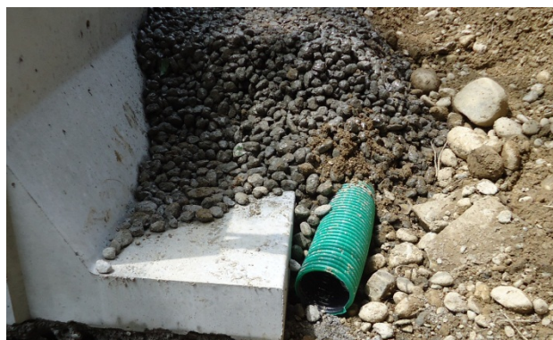
Bild 28: Einbau einer Sickerleitung mit Sickerpackung
