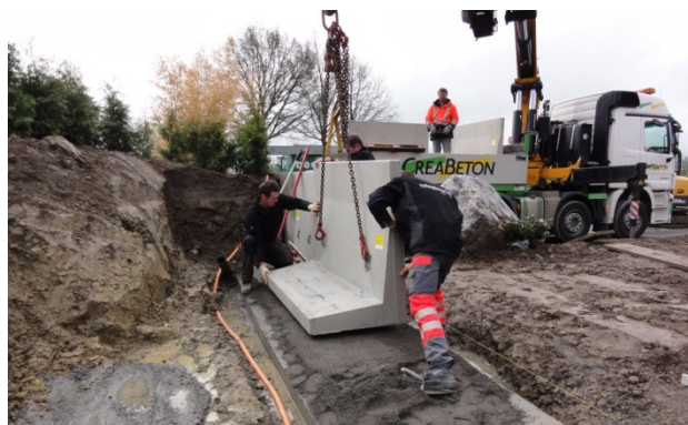
Bild 29: Versetzen der Winkelplatte auf ein Streifenfundament
