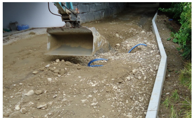
Bild 34: Lagenweises Einbringen von geeigneten Hinterfüllmaterial
