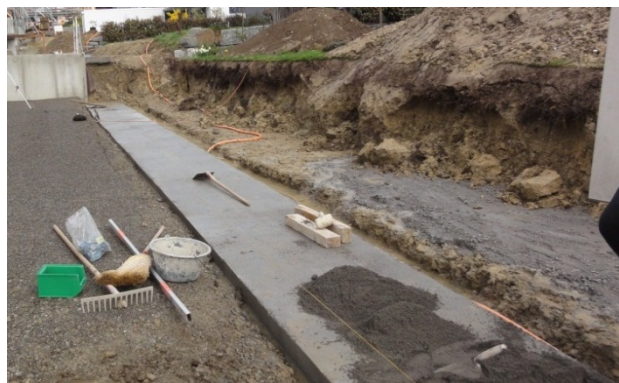
Bild 27: Erstelltes Streifenfundament
