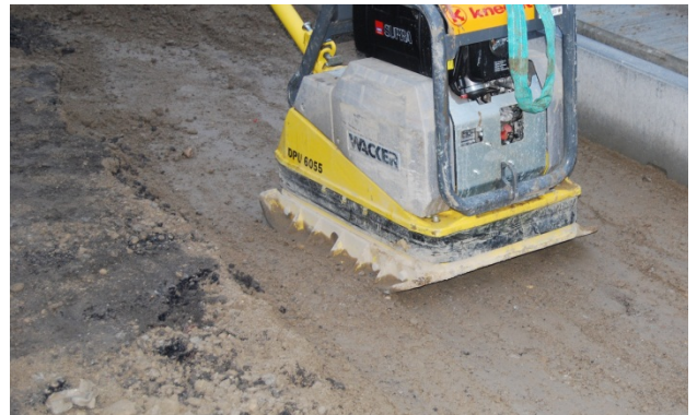
Bild 35: Verdichten nur mit leichten Verdichtungsgeräten
