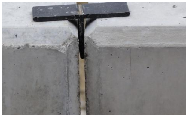
Bild 32: Optimale Fugen nach der Versetzung
