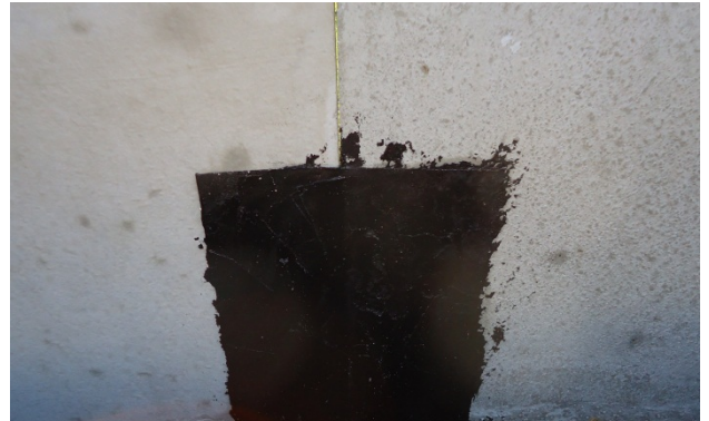
Bild 33: Abdichten der Fugen
