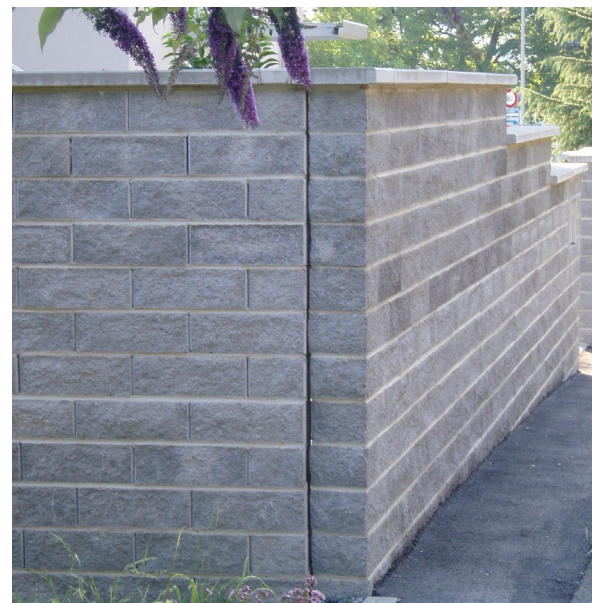
Bild 41: Dilatationsfuge (Produktneutral)
