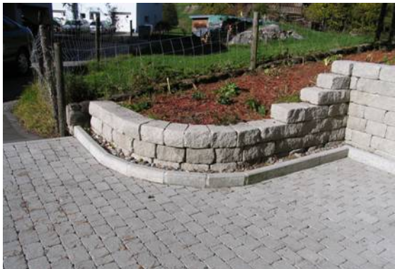
Bild 30: Maueraufbau mit SANTURO® Keilmauersteinen
