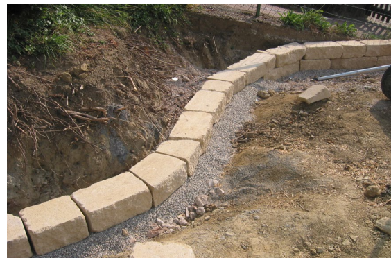
Bild 24: Versetzte erste Steinreihe in Kiesfundament
