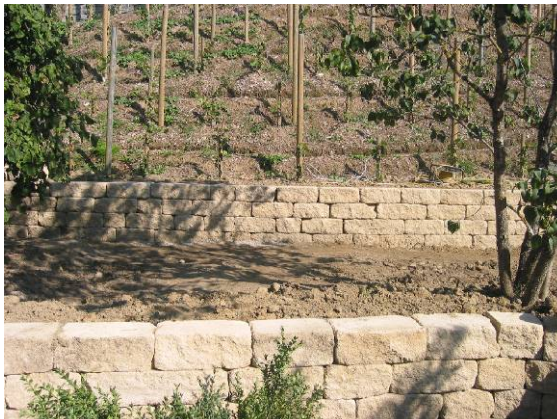
Bild 37: Senkrechte Trockenmauer
