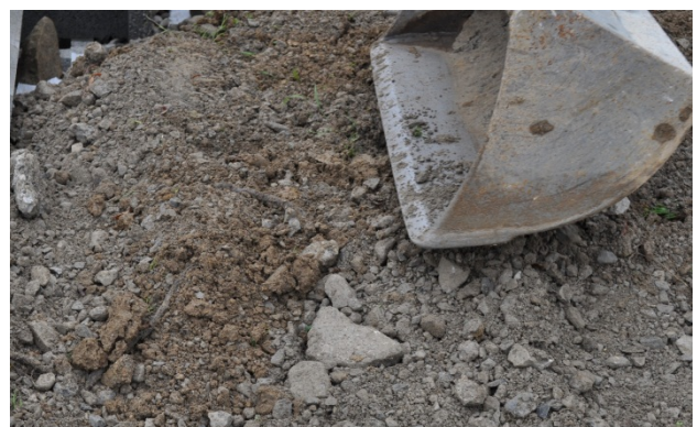
Bild 28: Lagenweises Einbringen von geeigneten Hinterfüllmaterial
