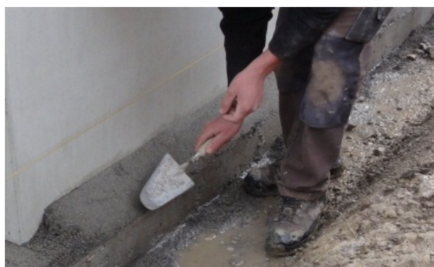
Bild 24: Erstellen der Fundamentnocken
