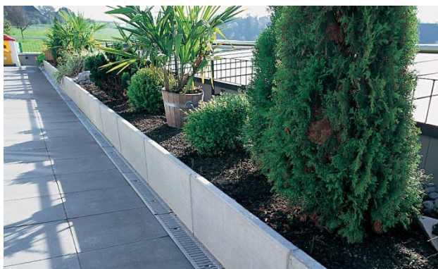
Bild 1: ROZTEC® MINI Winkelplatten als Böschungssicherung
