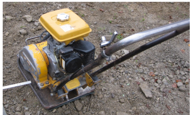
Bild 29: Verdichten nur mit sehr leichten Verdichtungsgeräten
