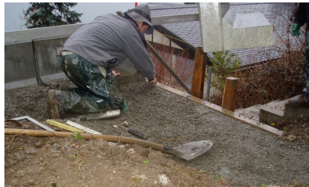
Bild 21: Erstellen des Streifenfundamentes
