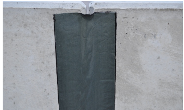
Bild 27: Abdichten der Fugen
