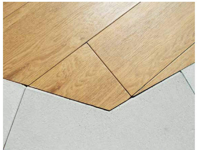
Bild 9: Passstück Feinsteinzeug Gehwegplatte
