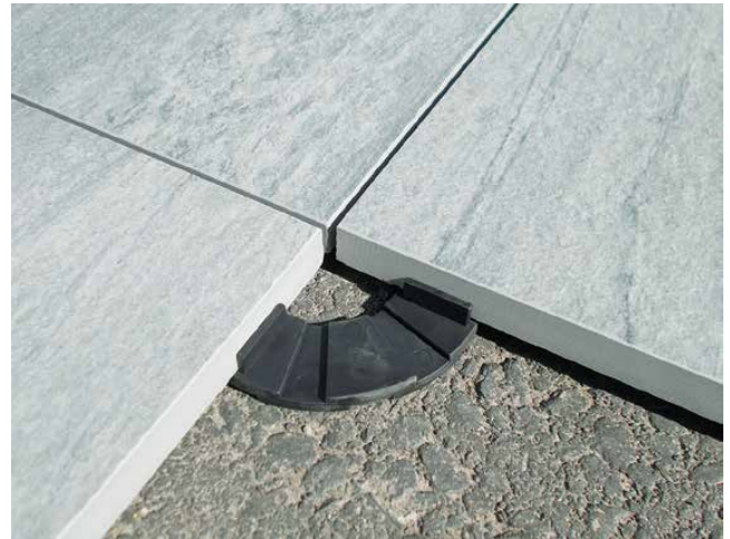
Bild 12: Verlegen der Feinsteinzeug Gehwegplatten auf Lagerringe
