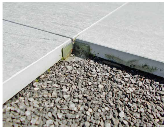
Bild 8: Verlegen der Feinsteinzeug Gehwegplatten in Bettungsschicht
