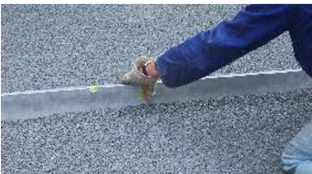
Bild 7: Bettungsschicht abziehen
