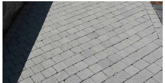
Pflasterfläche mit Passsteinen bei Randabschluss
