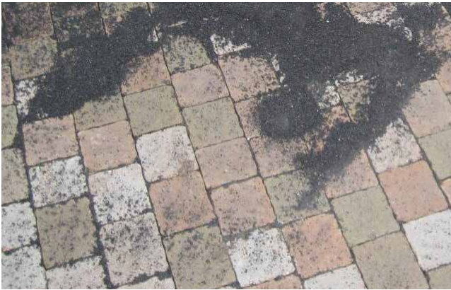
Einsanden der Fugen
