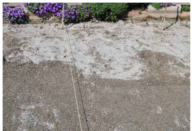
Richtschnur als Richtungshilfe oder für den Rasteraufbau
