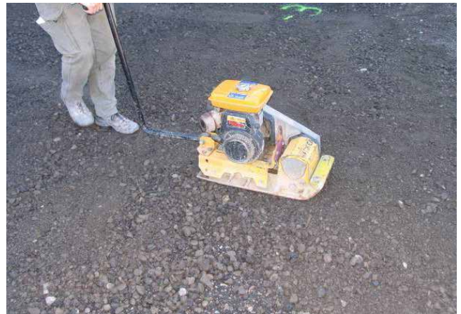
Verdichten der Fundationsschicht
