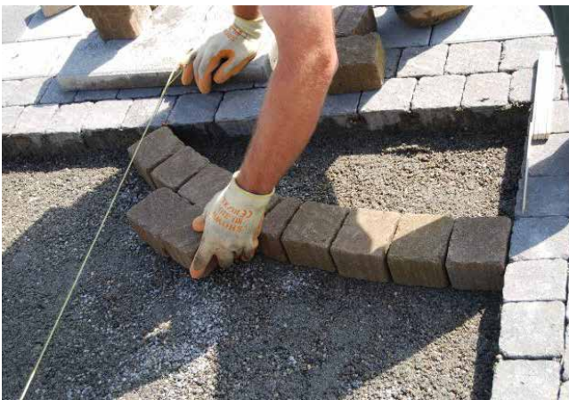
FRIEDA® Pflastersteine werden von Hand verlegt
